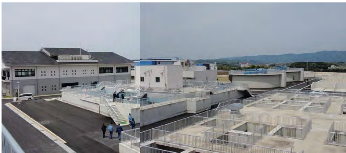
ソーラーパネル設置場所から、浄水場管理棟・急速ろ過池を望む
