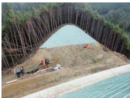
植生マット設置の様子
