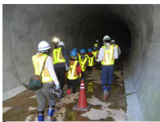
仮排水路トンネル内を歩きました
