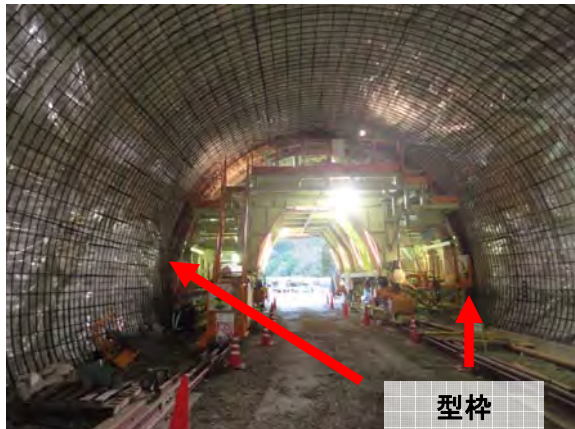
写真①: 仕上げコンクリート用型枠
