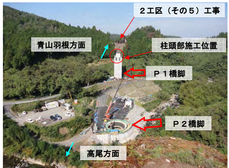
トンネル工事下流側より橋梁工事の全景を望む
