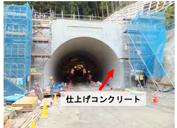
写真②: コンクリート仕上がり状況
