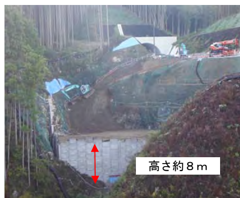
貯水池横断橋上流部整備工事 補強土壁 施工状況
