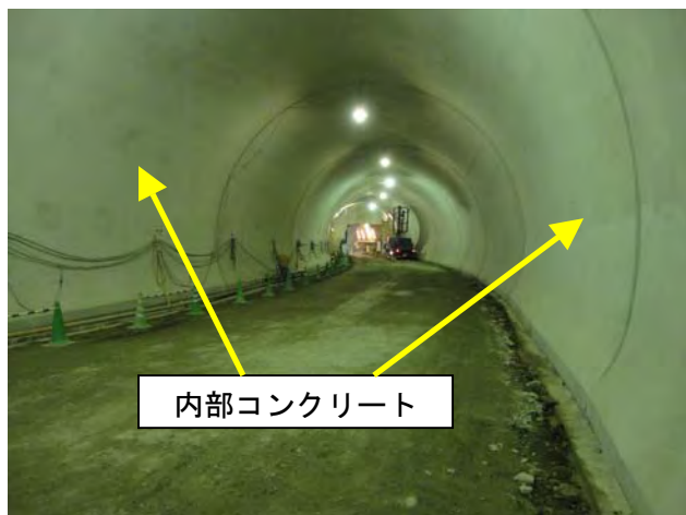
トンネル内の様子
