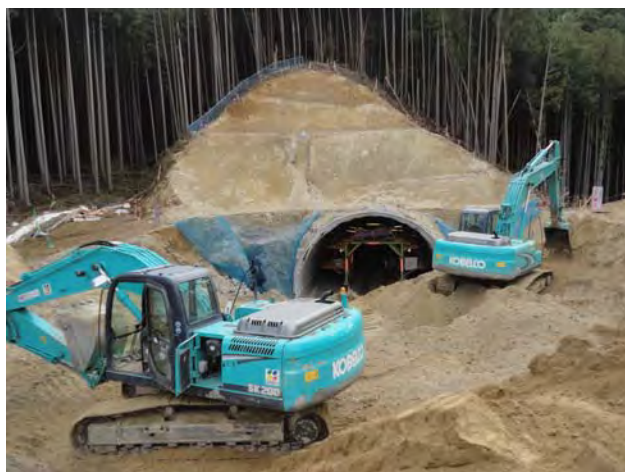
トンネル下流側道路工事の様子
