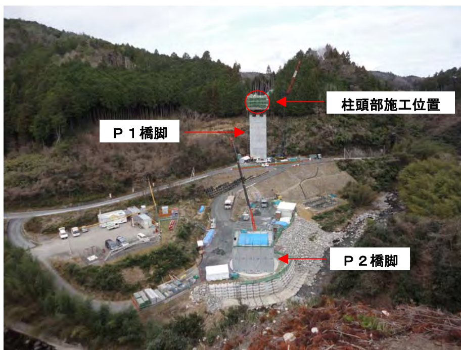
トンネル工事下流側より橋梁工事の全景を望む
