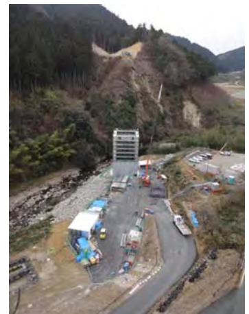
P1橋脚上部より小川内方面を望む
