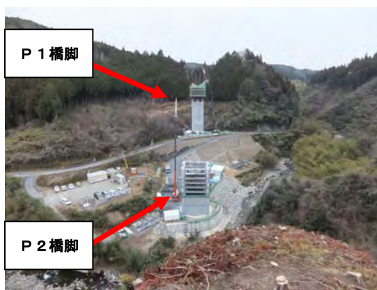
トンネル下流坑口より青山羽根方面を望む
