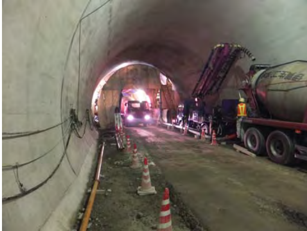
内部コンクリート施工の様子
