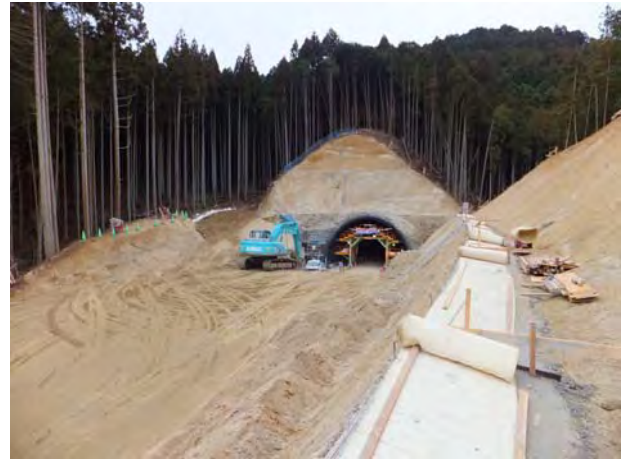
トンネル起点側地山掘削作業の様子
