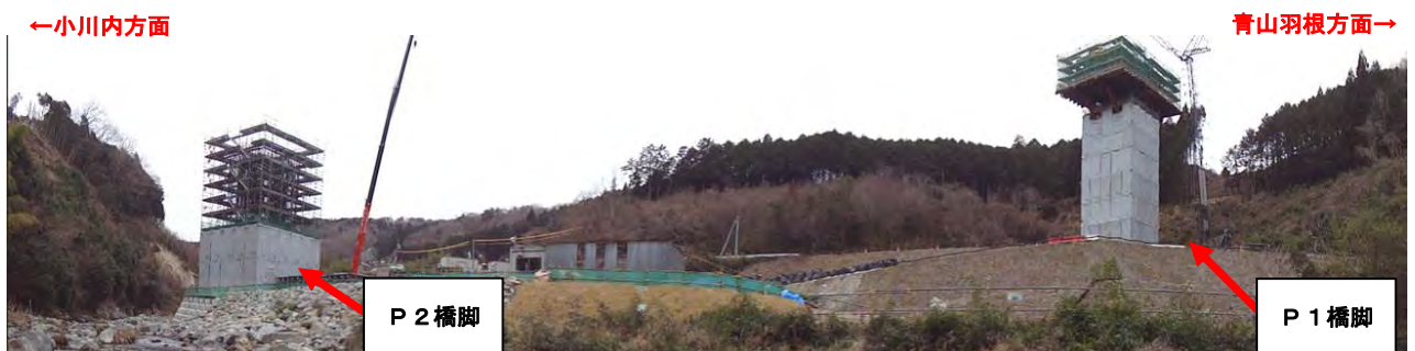
横断橋工事全景（下流から上流を望む）
