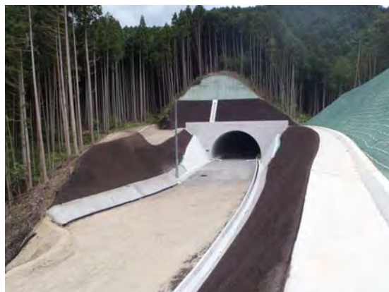
北野トンネル（青山羽根方面から望む）
