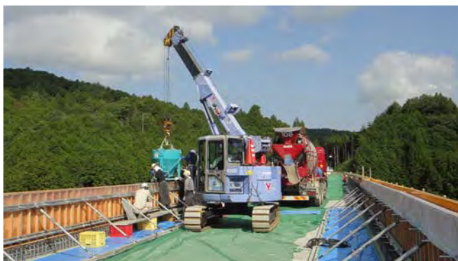
壁高欄 施工状況
