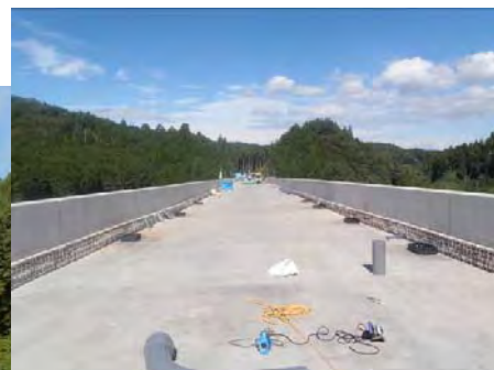
橋梁上部の施工状況
