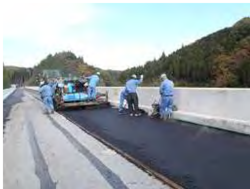
寒い中での舗装作業
