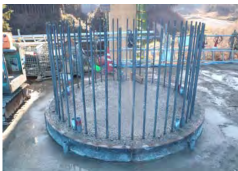
A1橋台 コンクリート打設翌日の深礎杭
