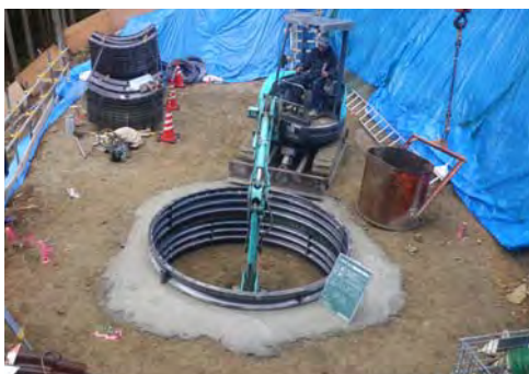
A1橋台 深礎杭の掘削状況
