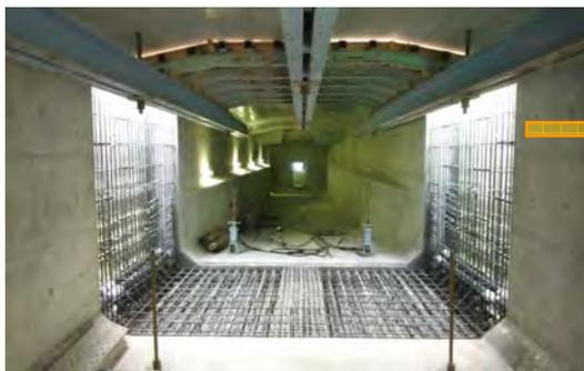
中央部（橋の内部）コンクリート打設前
