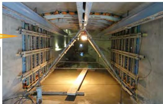
中央部（橋の内部）コンクリート打設後
