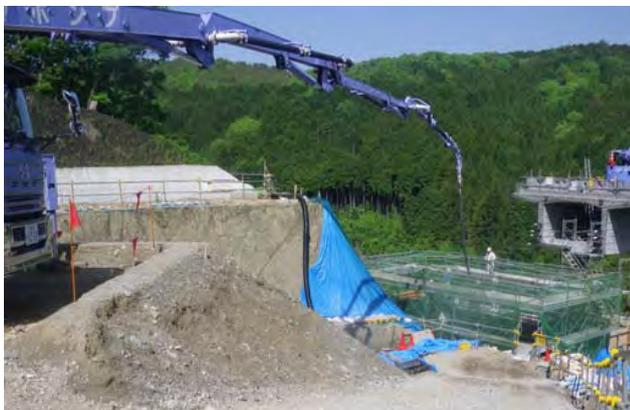
ポンプ車によるA2橋台コンクリート打設状況
