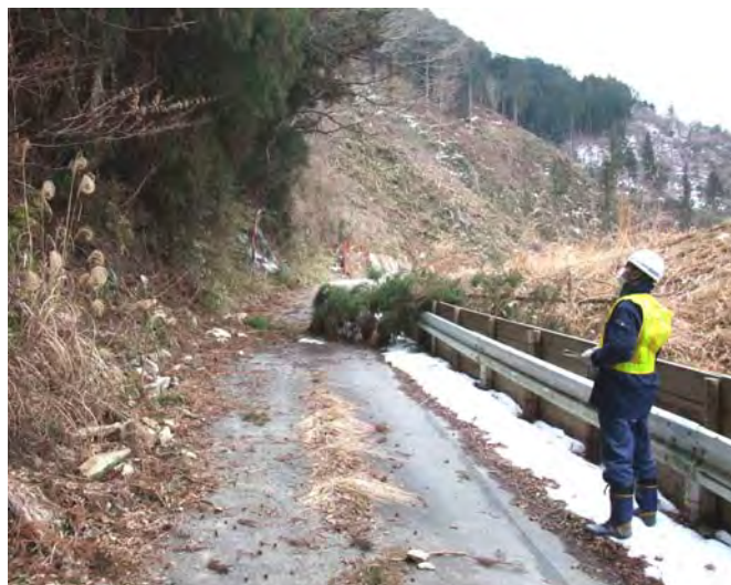
崩落がないかチェック中！
