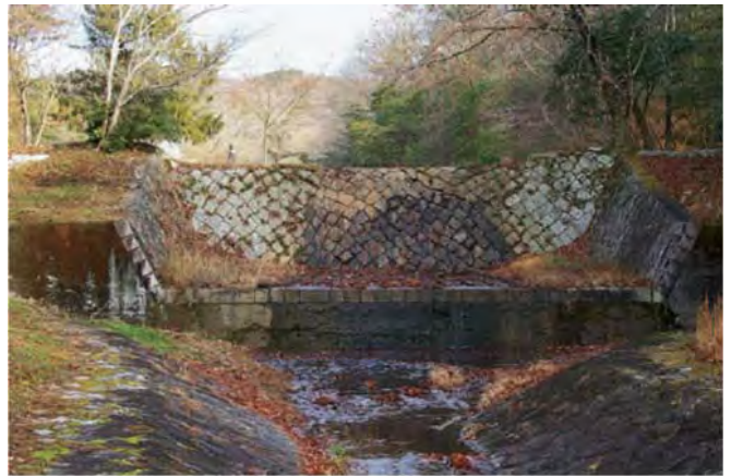
建設から136年後の今も立派に役割を果たしているデ・レーケが指導した堰堤群の一つ。第5堰堤。幅23m、高さ3.5m。切石の谷積み（角を立てて積み方）。
