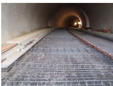
鉄筋付設状況
