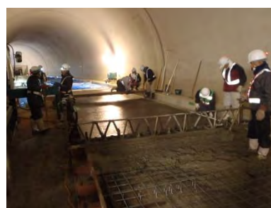
コンクリート打設状況
