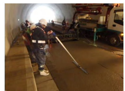
舗装施工状況
