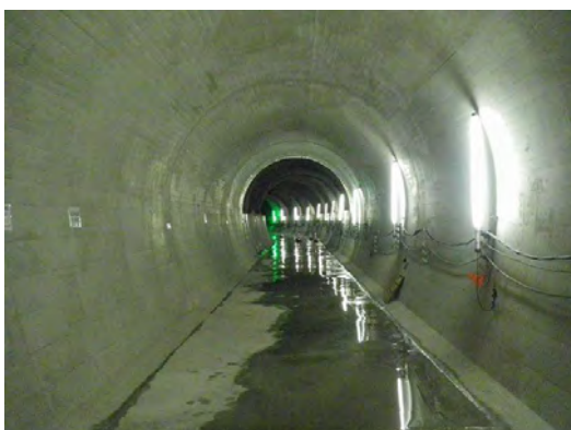
川上ダムの仮排水トンネルの内部
