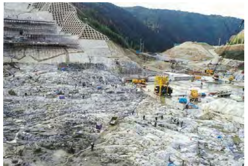
比奈知ダムの基礎地盤の状況
