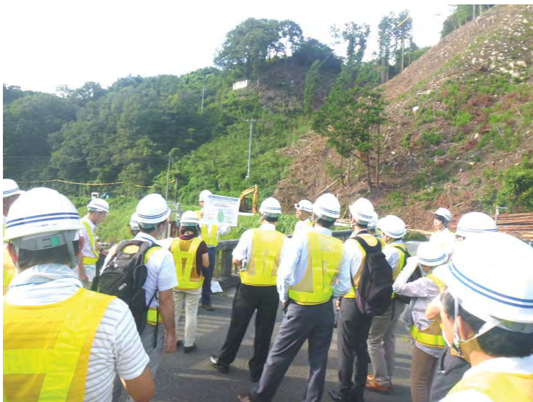
川上ダム建設予定地で説明を聞く委員のみなさん
