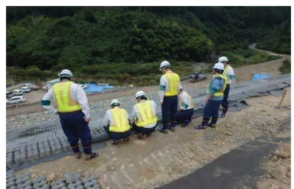
法面端部の状況確認
