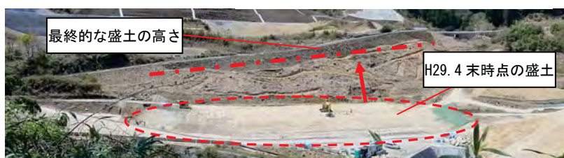
上川原地区の斜面对策工事の状況（H29.4末）
