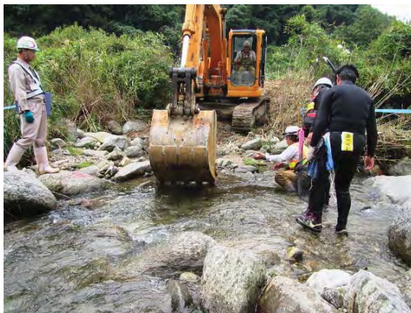
工事実施時に石をめくって調査している様子
