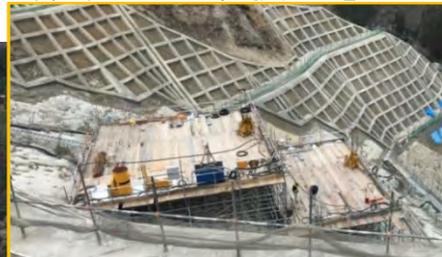
斜面に足場を組み平場を設けて施工します。
