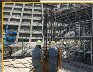
削孔してセメントミルクを注入します。
