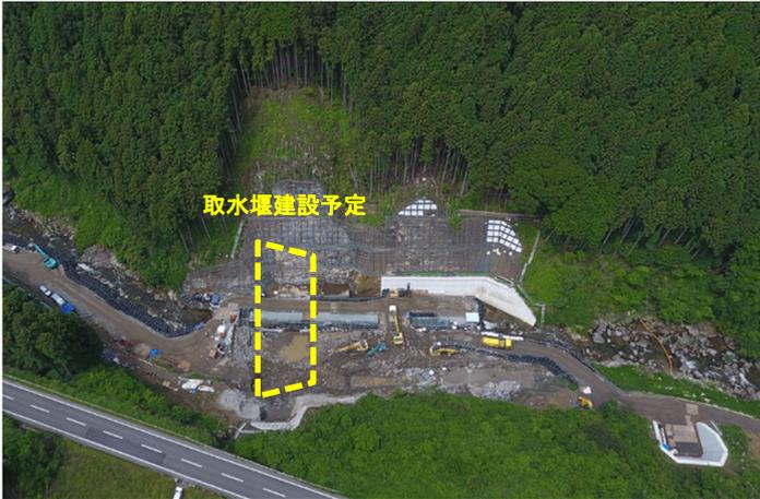
流入水バイパス取水堰建設地点（基礎掘削中）
