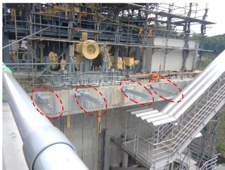
建屋②の鉄骨材の据付け
