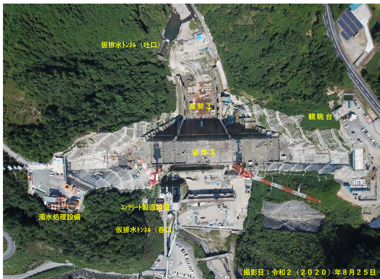
写真－4 川上ダムダムサイト（真上から）
