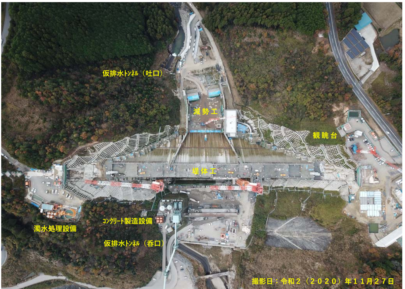
写真-4 川上ダムダムサイト (真上から)
