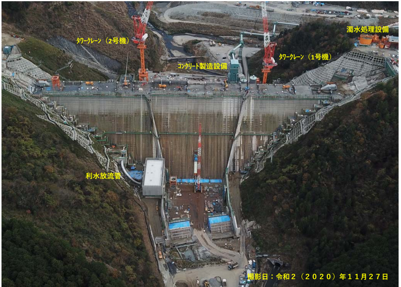
写真-1 川上ダムダムサイト（下流から上流を望む）
