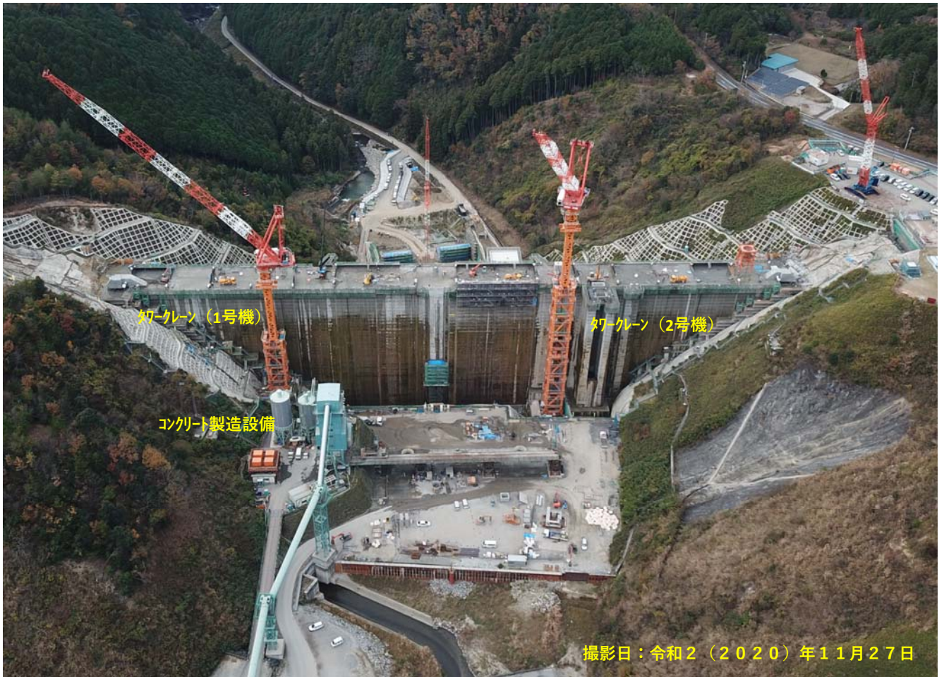
写真-3 川上ダムダムサイト (上流から下流を望む)
