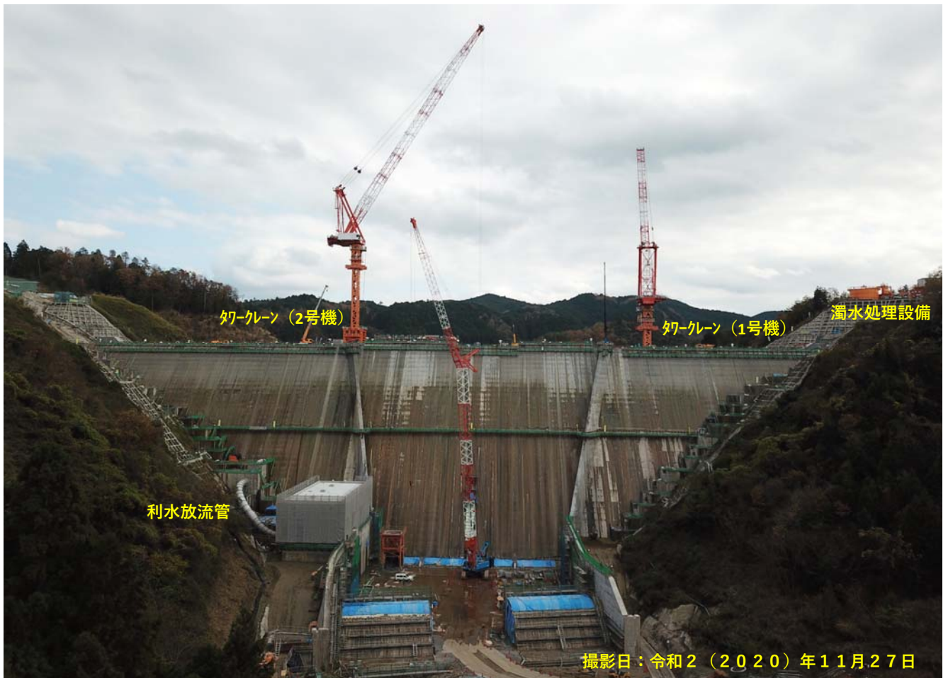
写真-2 川上ダムダムサイト（下流から上流を望む）
