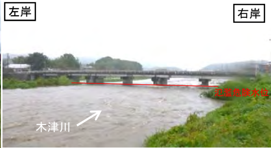
比土地点(比土橋)の状況 (令和元年10月12日15時撮影)
