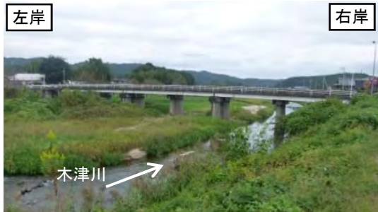
比土地点(比土橋)の状況(平水時)
