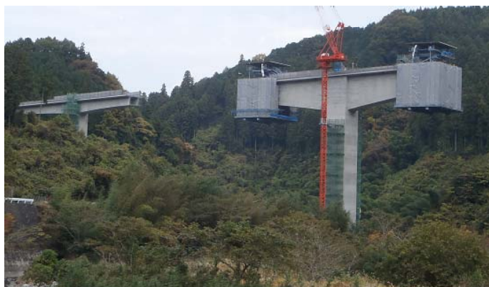
猫また大橋（工事中：H24.11.9現在）
