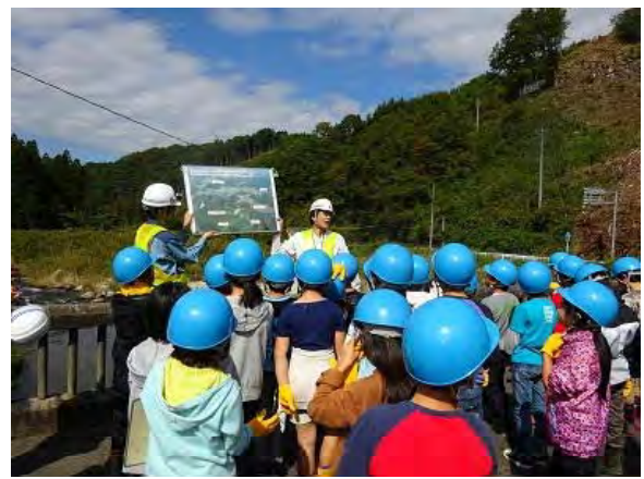
ダム建設予定地の見学
