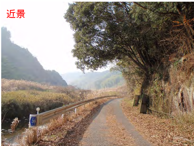
現道(西之沢橋上流付近)
