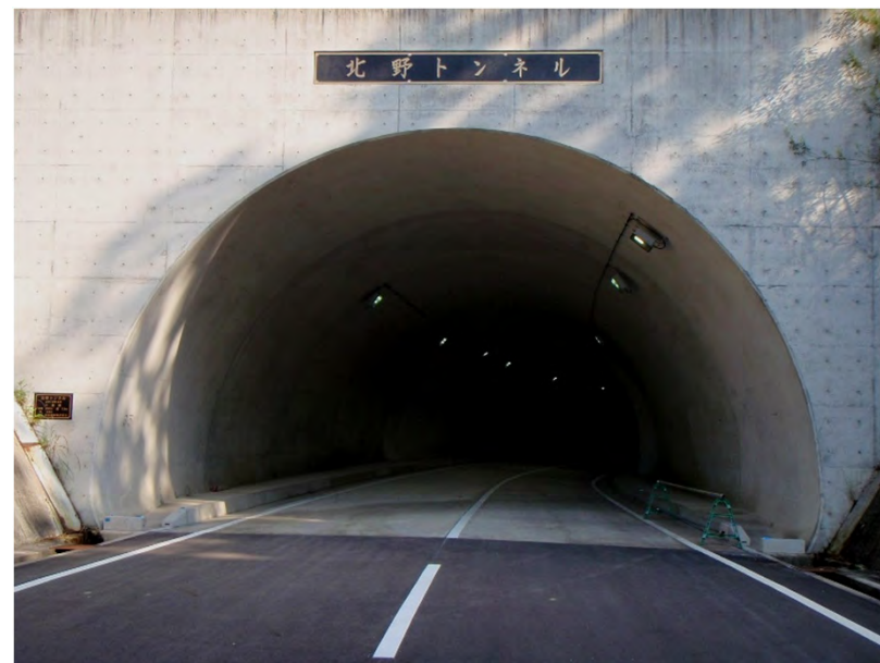
付替(北野トンネル)
