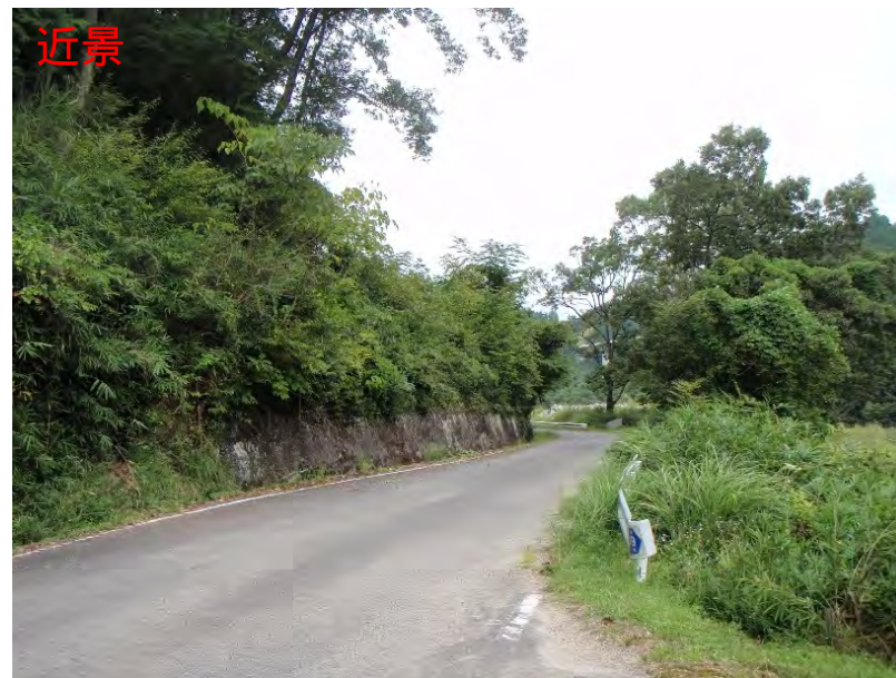
現道(字廣代付近)
