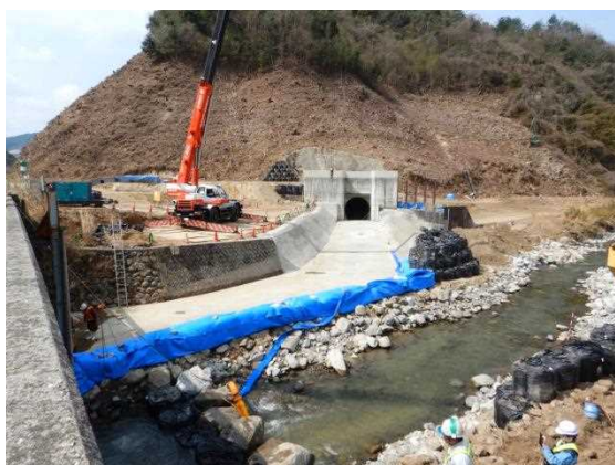
転流前の状況
