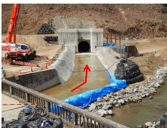
まもなく流れが仮排水トンネルに到達
