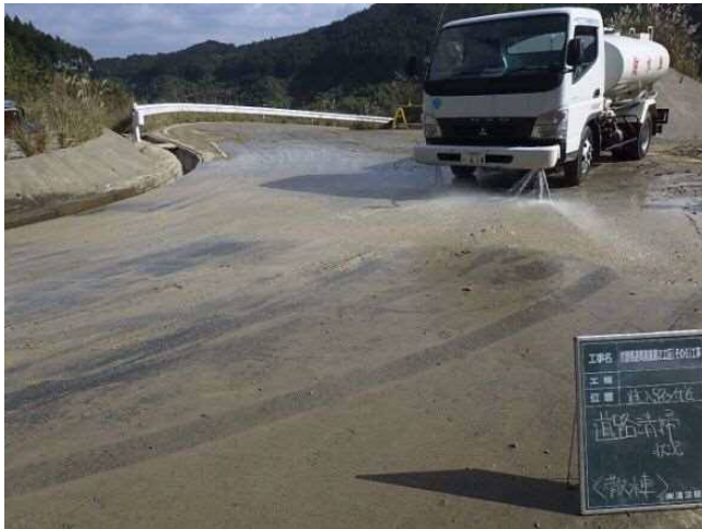
散水車による散水状況
