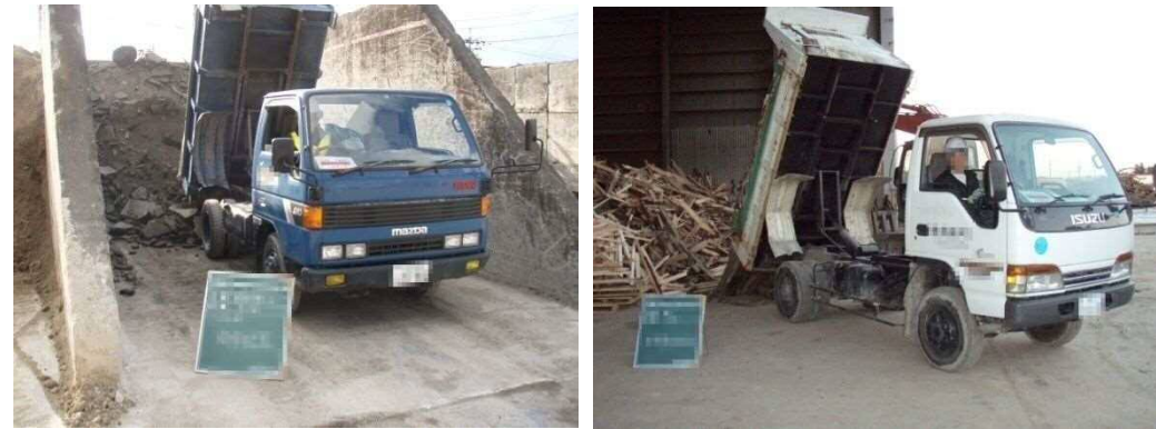
再資源化施設への搬入状況 (左写真はアスファルト殻、右写真は木材)
