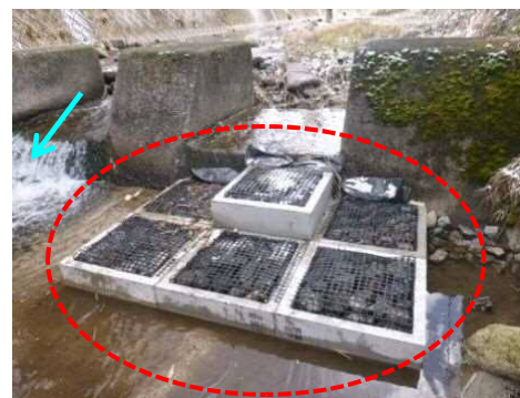
設置した遡上路
