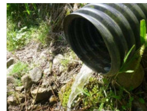
沈砂池から河川への排水状況
