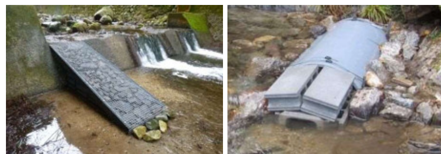
設置した遡上路
