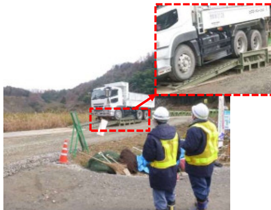
乾式タイヤ洗浄機の稼働状況
