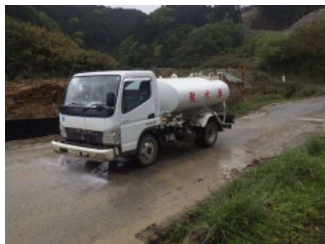
散水車による散水状況
