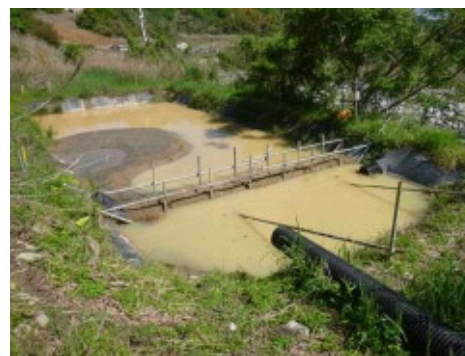
沈砂池の設置状況
