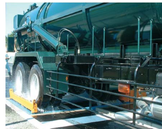
工事用車両タイヤ洗浄状況(事例)
