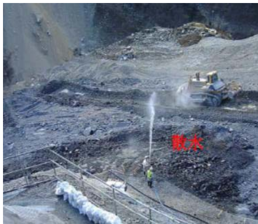
散水作業状況(事例)
