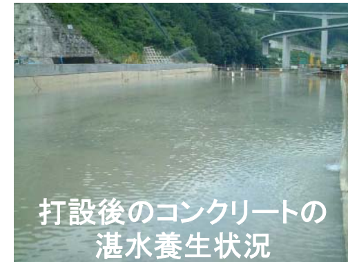
打設後のコンクリートの養生状況
