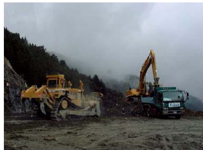
河床で掘削土砂・岩石を積込み運搬
