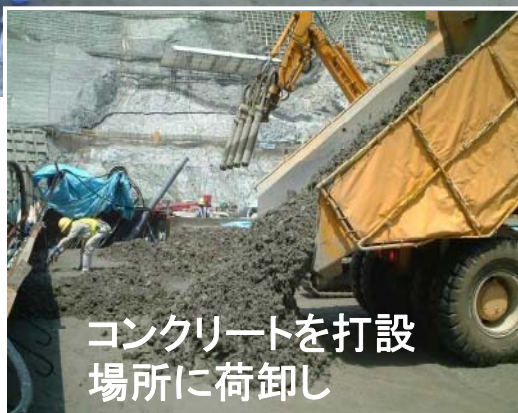
コンクリートの締固め(内部振動機)
