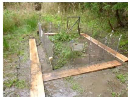
フェンスの改修 (平成29年4月)
