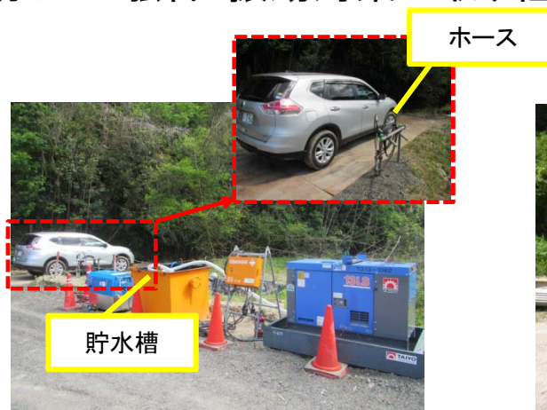
車両洗浄機の稼働状況
