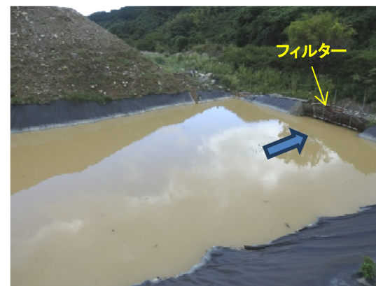
沈砂池の設置状況
