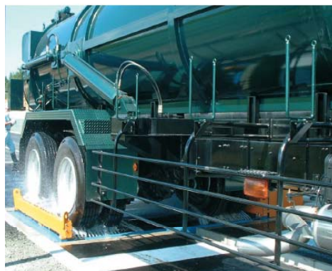
工事用車両タイヤ洗浄状況(事例)
