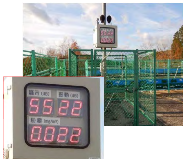
騒音・振動・粉じんの計測値を表示 (右岸天端)
