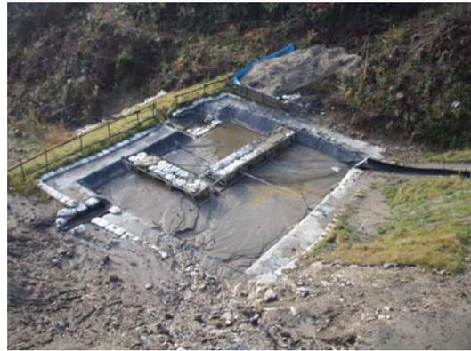
写真 2.4-4 沈砂池の設置状況
