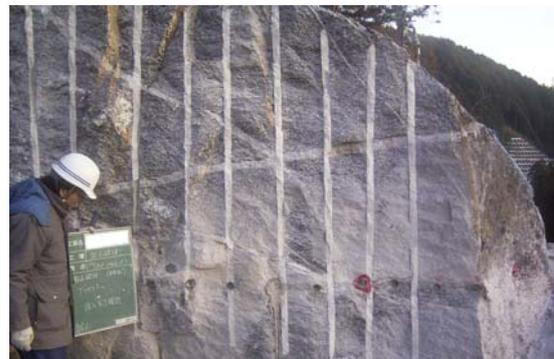
写真 2.4-8 騒音の低減（静的破碎工法）
