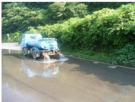
写真 2.4-1 散水の実施状況
