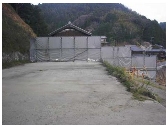
写真 2.4-2 防音壁の設置状況
