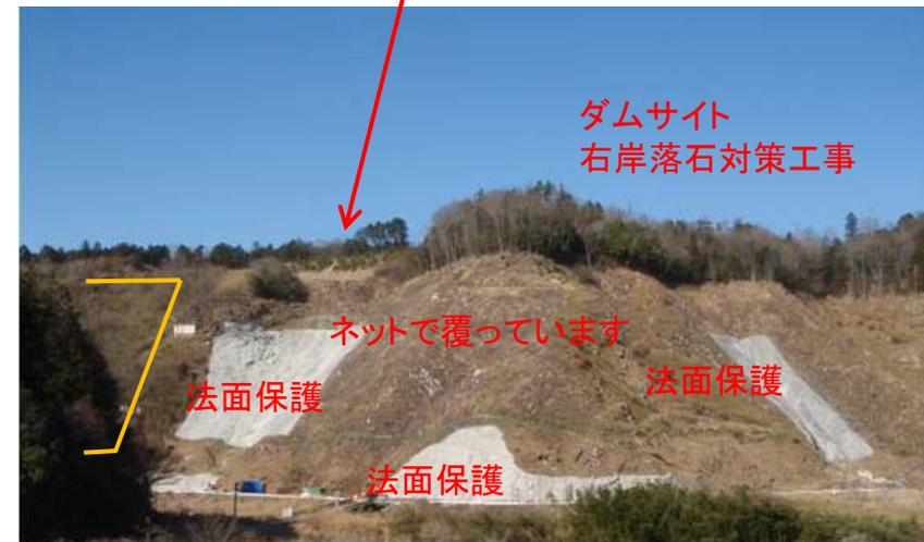
ダム本体工事の際、斜面の下にある道路を通行するため地表に見えている大きな岩が落ちないように対策します
