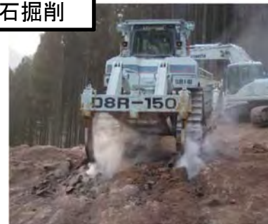
掘削土砂・岩石の押し落とし
