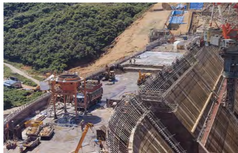
拡張レヤ工法(布目ダムの施工状況)
