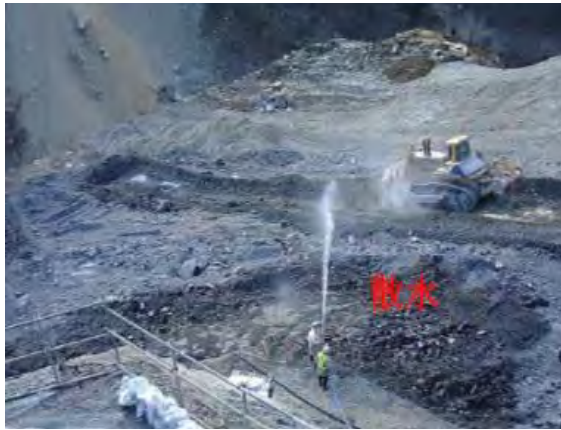
散水作業状況
