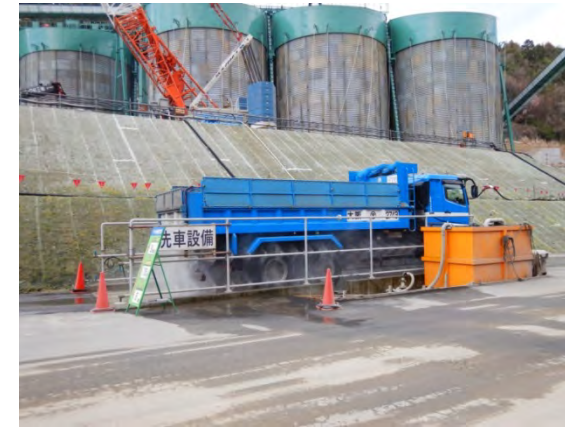
工事用車両タイヤ洗浄状況
