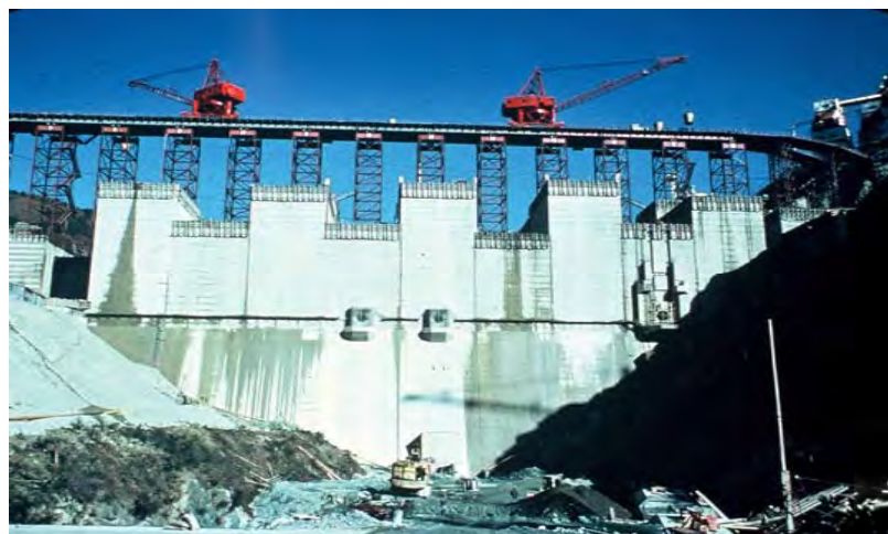
従来の工法(下久保ダム(群馬県、埼玉県))
