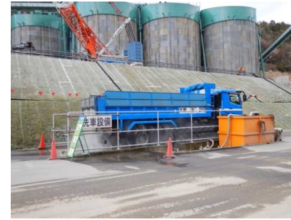
工事用車両タイヤ洗浄状況
