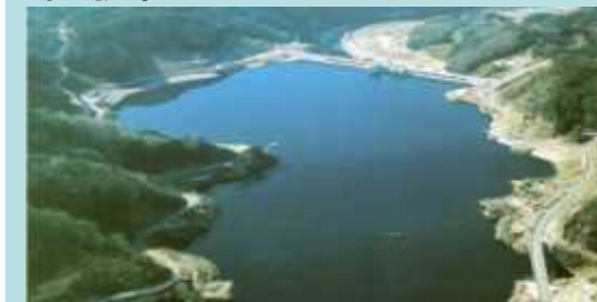
試験湛水(写真は比奈知ダムの事例)
