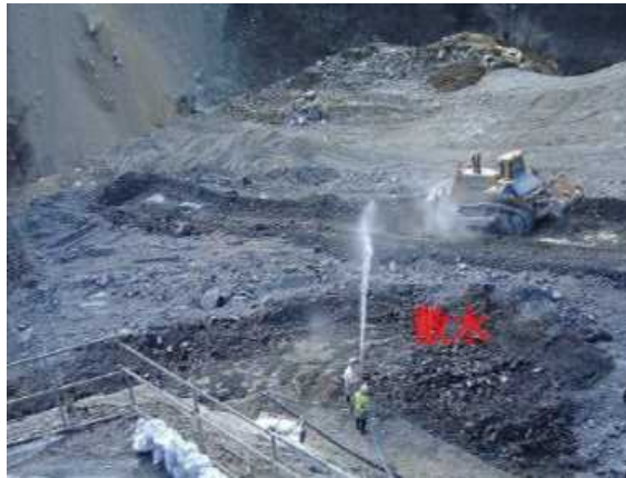
散水作業状況
