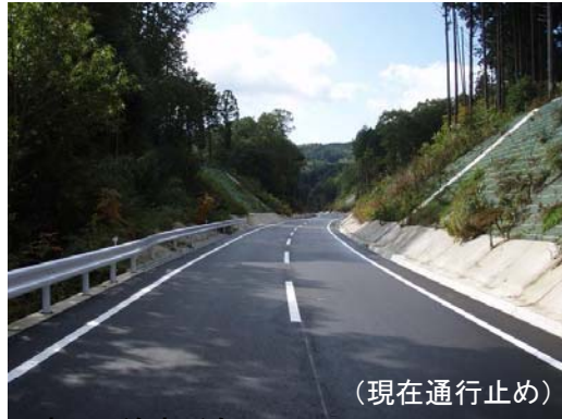
(平成20年11月17日 全線供用開始) 松阪青山線(要石大橋)
