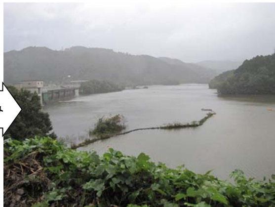
貯留後 EL282.45m (23日7時) 水位上昇 4.18m
