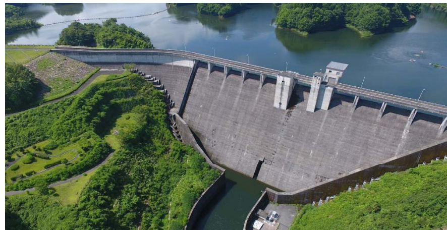
布目ダム全景
