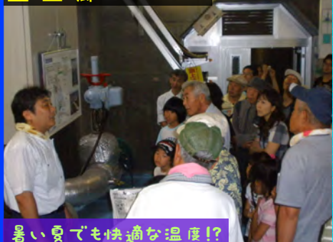
ひんやり涼しい地下通路 監査廊
