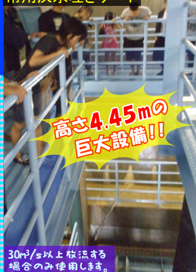
洪水を調節する 常用洪水吐きゲート
