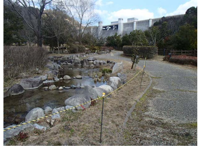
●立入制限用ロープ設置状況
