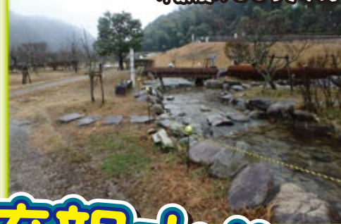
作業後のせせらぎ水路
