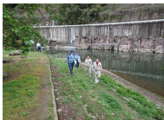
長瀬河川親水公園点検状況
