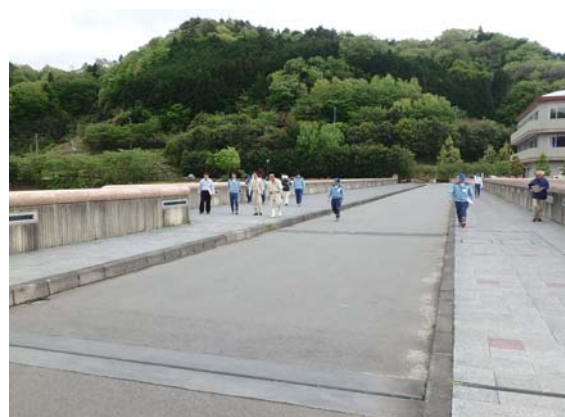
ダム天端歩道点検状況
