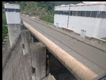
展望室から 天端側水路を望む
