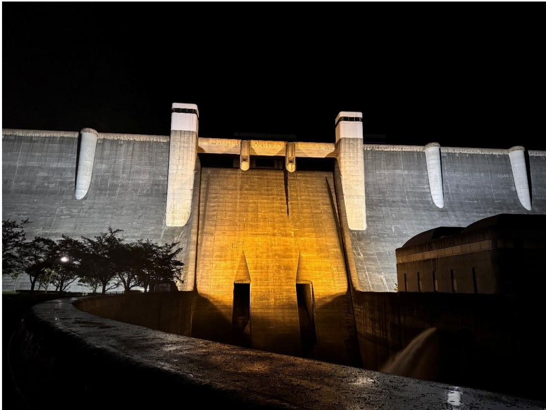
下流からダムを望む
