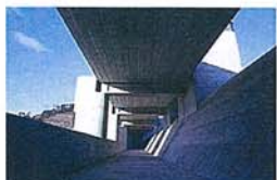
非常用洪水吐き (天端側水路)
