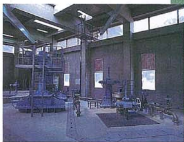
主管放流設備(左)と分岐管放流設備(右)
