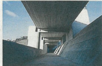
非常用洪水吐き (天端側水路)
